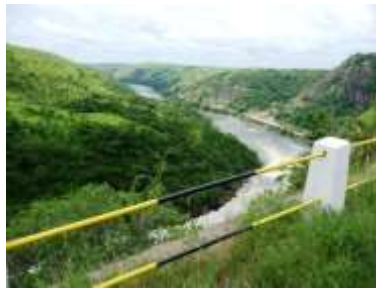
Vistas da Barragem de Cambambe
